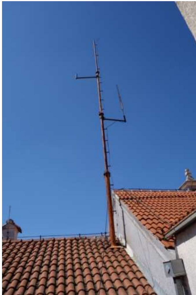
Slika 3. Zgrada gradske uprave - postojeći antenski stup
